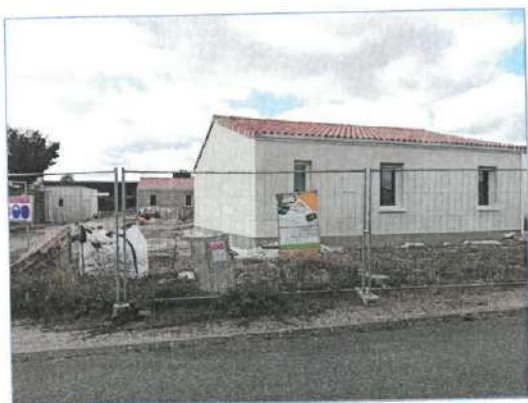
Chantier en cours d'Habitat de la Vienne
